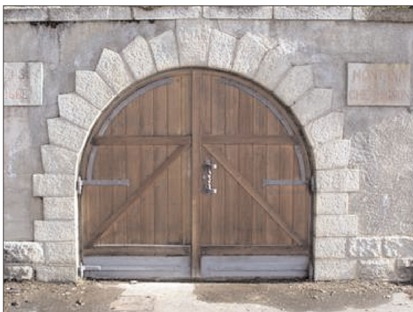
La porte d'entrée du tunnel à Plans-Mayens.
