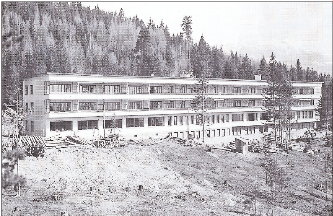
Construction du Sanaval.
