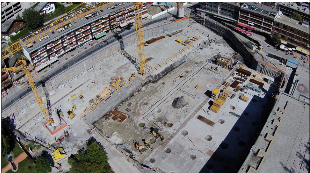
Photo du chantier en octobre 2014 réalisé par un drone.
