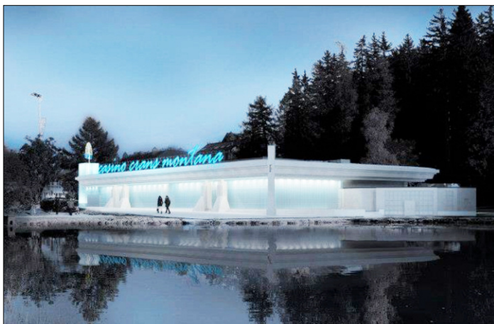
Le projet de réfection des façades du Casino qui sera entrepris en 2015.
